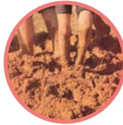
2. Amasado de la mezcla mediante los pies o herramientas simples como palas y picos hasta alcanzar una homogeneidad y consistencia blanda (estado plástico).
